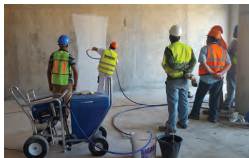
Formation sur chantier
